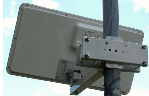
Det medfølgende mastebeslag er ikke optimalt, da der er langt mellem de 4 bespændingsbolte. Derudover mangler beslaget tænder som kan "bide" sig fast i røret. Bommen mellem antennen og mastebeslaget måler 40 cm. Alternativt er der mulighed for at montere beslaget på muren med 4-6 rawplugs.
